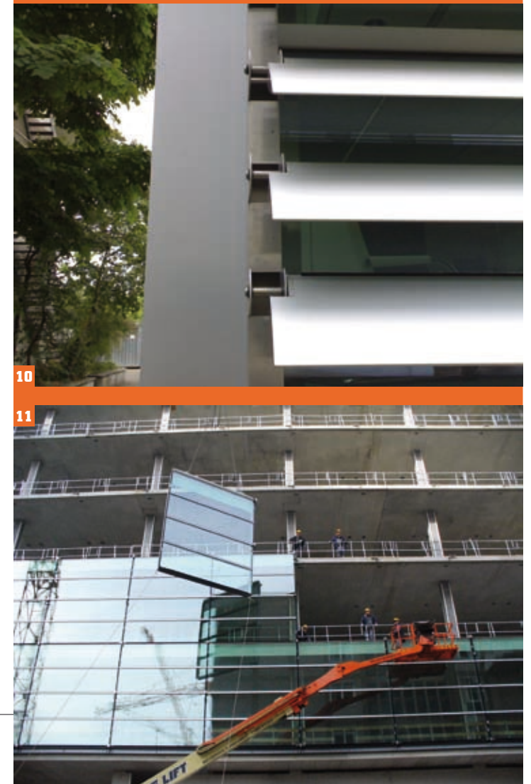
10. Campus Novartis, Basilea: mock-up frangisole 11. Campus Novartis, Basilea: montaggio cellule
