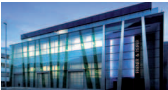
FACCIATE INTEGRATE CON MODULI ENERGETICI MULTIFUNZIONALI. A partire dal 2013 il fronte sud di Frener & Reifer sarà dotato di una facciata con moduli multifunzionali che combinano le funzioni di fotovoltaico, solare termico, areazione e protezione solare
